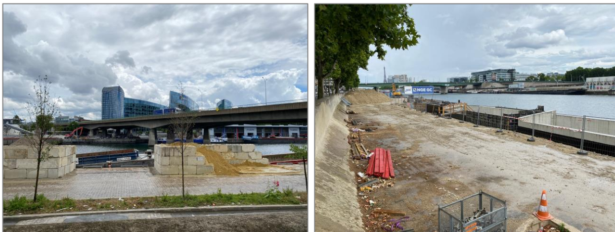
Figure 2 : Illustration des matériaux stockés en vrac et des aménagements en cours de réalisation au cours de la campagne de mesures au Port du Point du Jour (à gauche : zone d'activité temporaire période 2022, à droite : zone d'activité future en travaux 2022)
